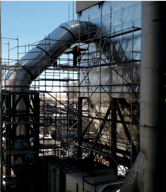
Trabajos en altura realizados por personal especializado y certificado en armado y desarmado de andamios multidireccionales Lahyer en Nueva Planta de Cal (Proyecto Katawi Rumi – Cesur) Caracoto - Puno
