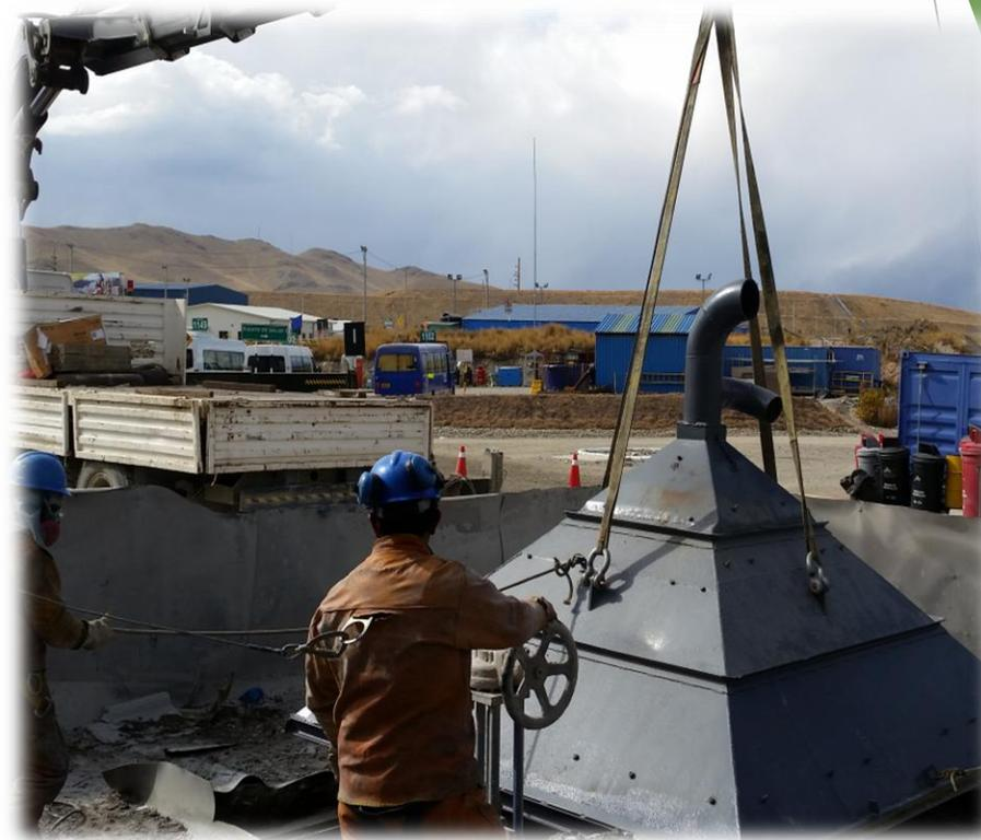
**Fabricación y montaje de campana tipo techo para cajón – descarga de relaves Antapaccay.**
